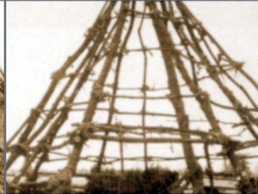
3/11 - Eliminazione del palo centrale
