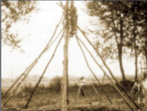
1/11 - Il palo centrale provvisorio con gli 8 pali portanti principali
