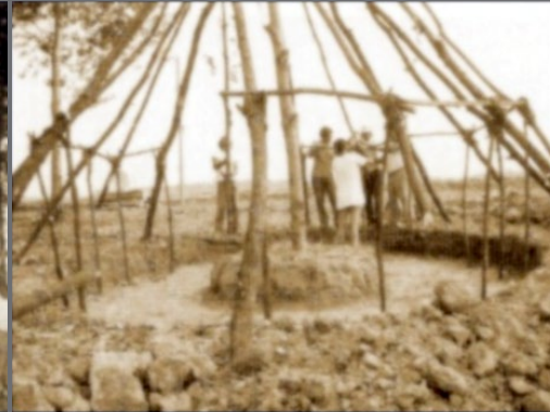
2/11 - Struttura principale portante appoggiata al palo centrale
